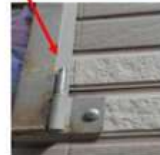
說明：經查一同掉落之鐵格柵，其鉸鏈皆完好無損，研判為勞工進行窗台鐵格柵復歸作業時，疑重心不穩，導致罹災者及鐵格柵一同從開口處墜落至地面。
