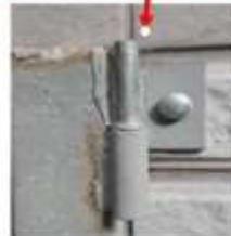
說明：經查一同掉落之鐵格柵，其鉸鏈皆完好無損，研判為勞工進行窗台鐵格柵復歸作業時，疑重心不穩，導致罹災者及鐵格柵一同從開口處墜落至地面。
