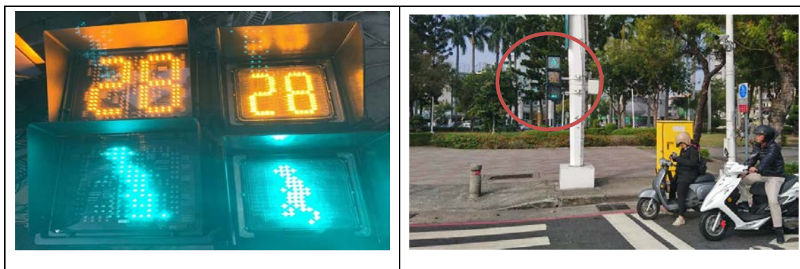
圖 100 放大型行人專用號誌示意圖
