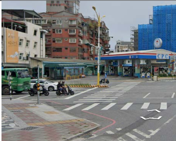
15. (中央路)與中山路之路口處行人號誌燈、行穿線、路緣斜坡及左轉車道、共桿
