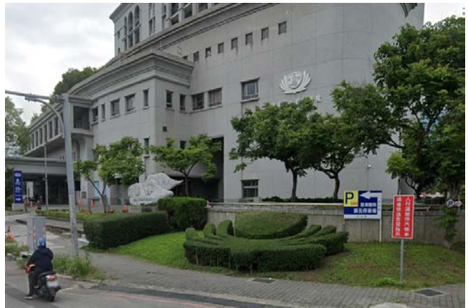
16. (中央路)慈濟醫院拆除人行陸橋後之路口及人行道禁停汽機車標誌
