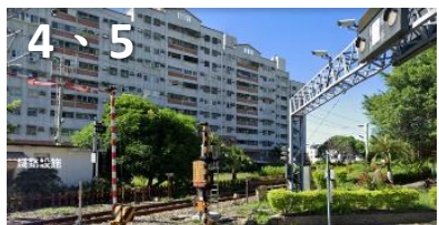
4、5 軌道西側與中華路之間綠地、鐵路設施
