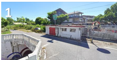
1 中原地下道上方及花東縱軌之交叉路口
